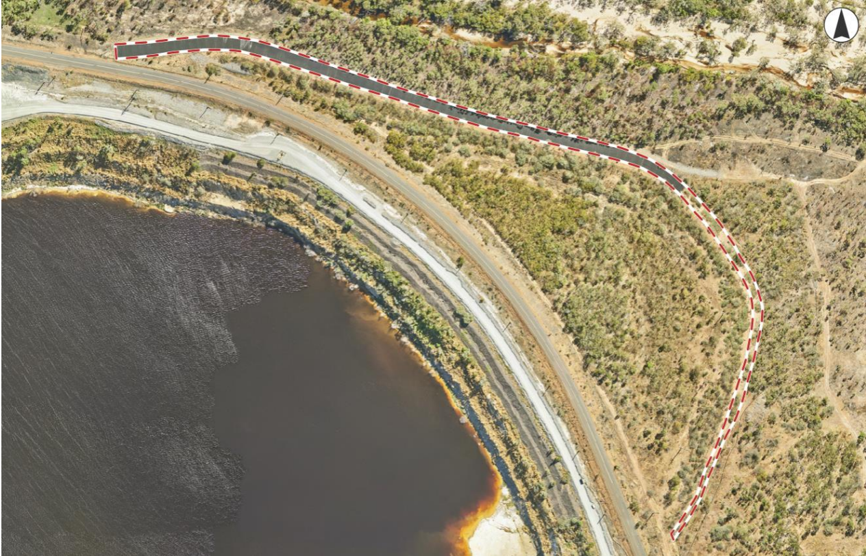
Plate 4-25: Magela Levee (June 2023)
